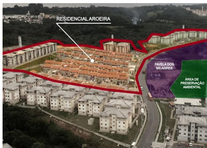
Figura 1 – Implantação do empreendimento Aroeira I, II, III e VI destinado para reassentamento de famílias.
